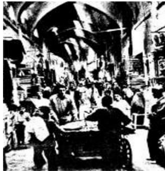
Basar in Yekawa; Hochburg der Schah-Palace
